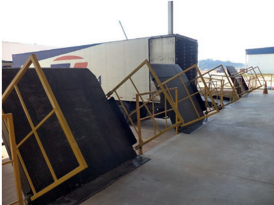
ACESSOS PARA CARGA E DESCARGA DO GALPÃO EXISTENTE
