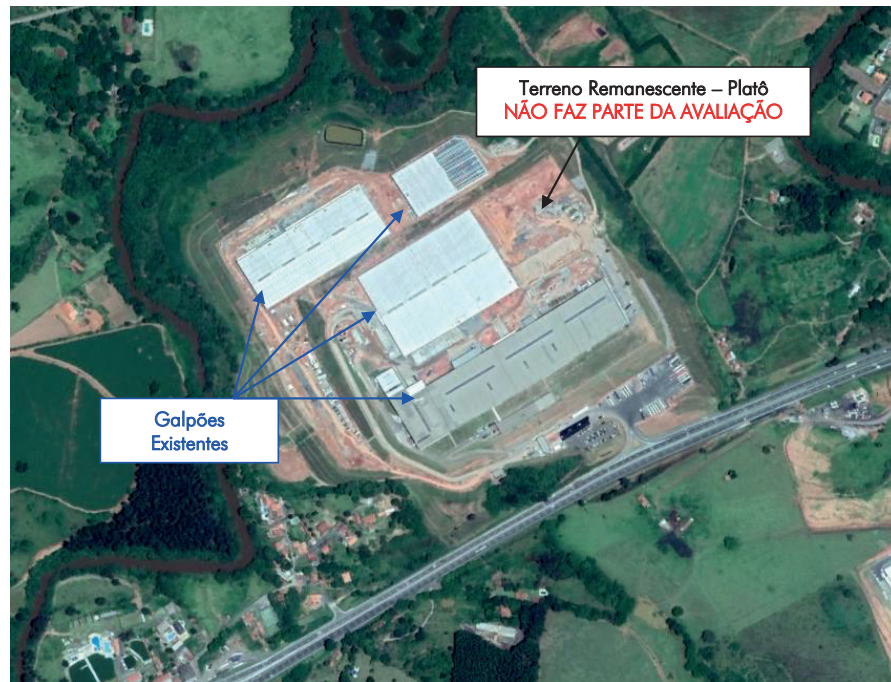
Figura 1 – Foto Aérea do terreno com destaque para o galpão atual e expansão.
