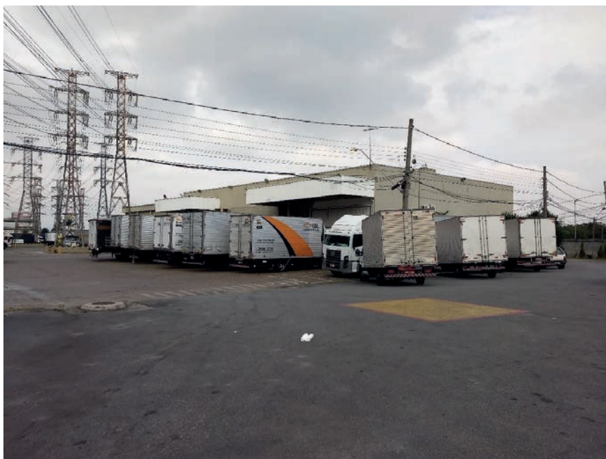
ÁREA DE MANOBRAS E PRÉDIOS DE APOIO
