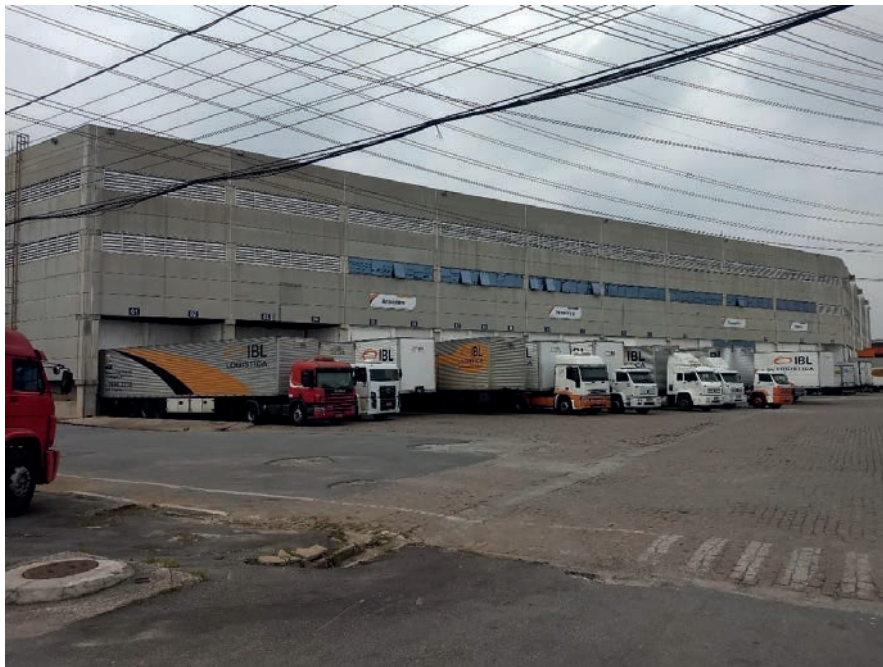
ÁREA EXTERNA DO GALPÃO
