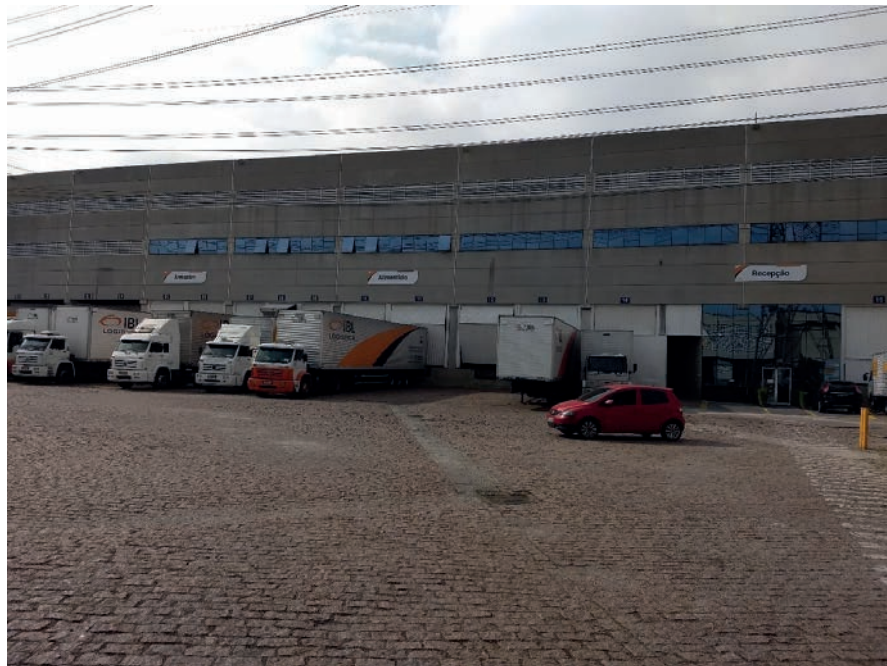
ÁREA EXTERNA DO GALPÃO
