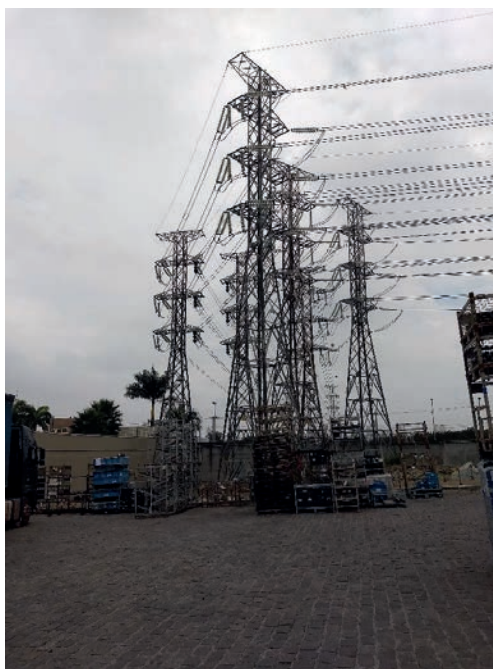
TORRES DA LINHA DE TRANSMISSÃO
