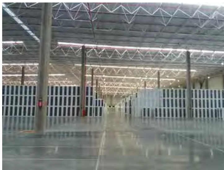
Vista interna do galpão
