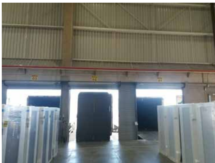
Área de marquise e galpão
