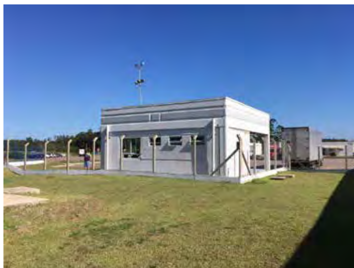
Vista geral do imóvel
