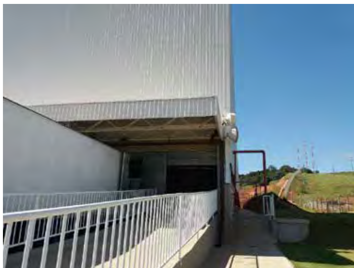
Área de marquise e galpão
