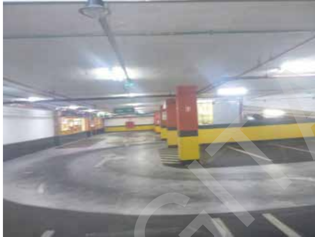
ASPECTO INTERNO DO AVALIANDO – PISO L1 E G2 - GARAGEM
