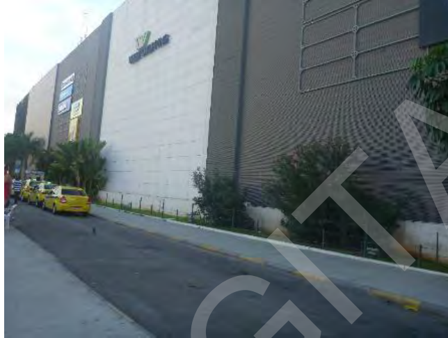
ASPECTO DA FACHADA DO AVALIANDO
