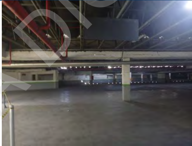
ASPECTO INTERNO – PISO G3 – GARAGEM
