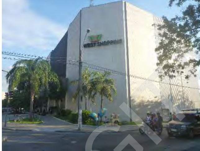
ASPECTO DA FACHADA DO AVALIANDO
