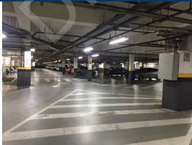
ASPECTO INTERNO DO AVALIANDO – PISO G1 – GARAGEM
