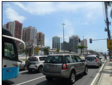
Avenida das Américas sentido Avenida Ayrton Senna
