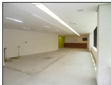
Refeitório em reforma para instalação de piso vinílico - Unidade 218
