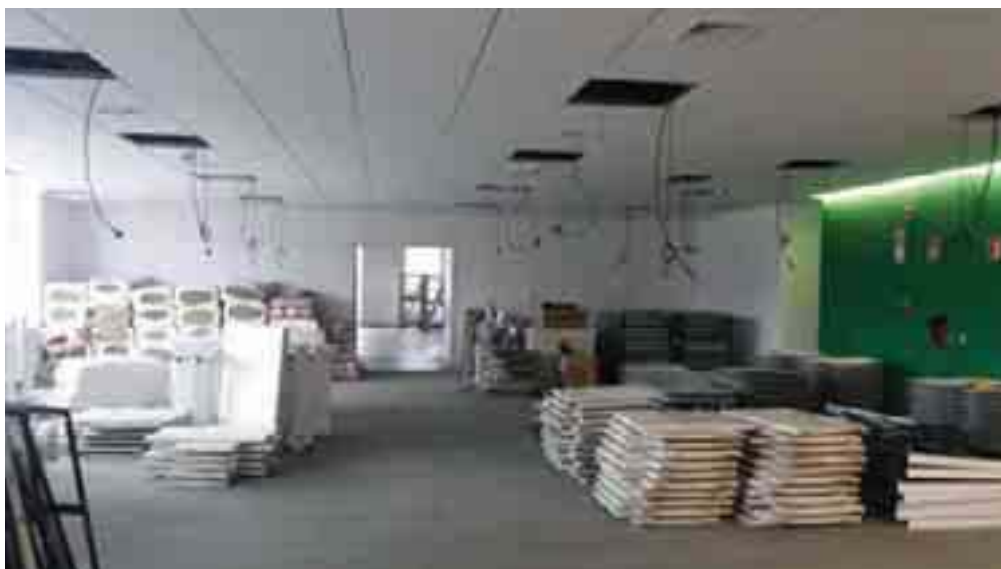
Vista geral dos escritórios
