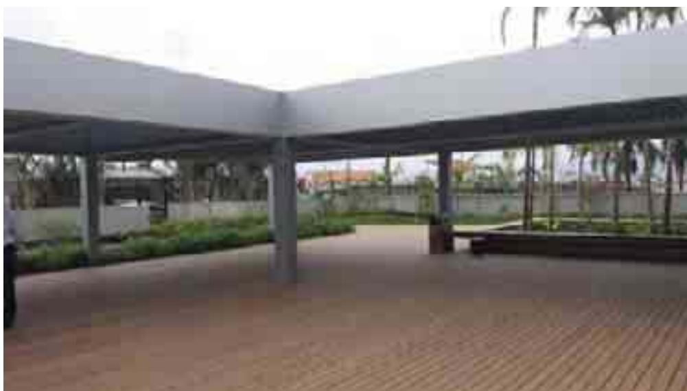
Vista externa do térreo
