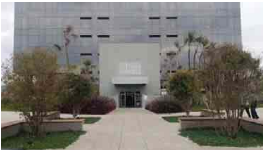
Vista do acesso ao edifício
