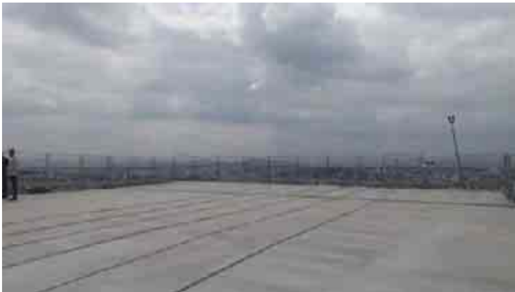
Vista geral da cobertura do edifício
