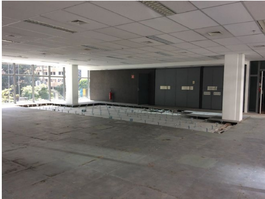
ÁREA DE ESCRITÓRIOS DO PAVIMENTO TIPO
