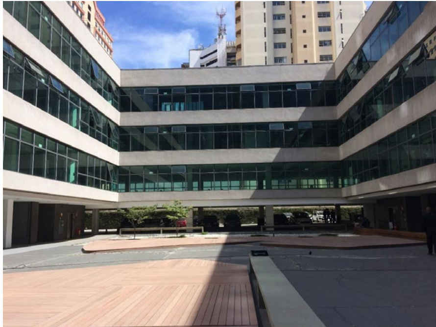
PÁTIO INTERNO DO EDIFÍCIO – ACESSO AOS ELEVADORES E CIRCULAÇÃO INTERNA
