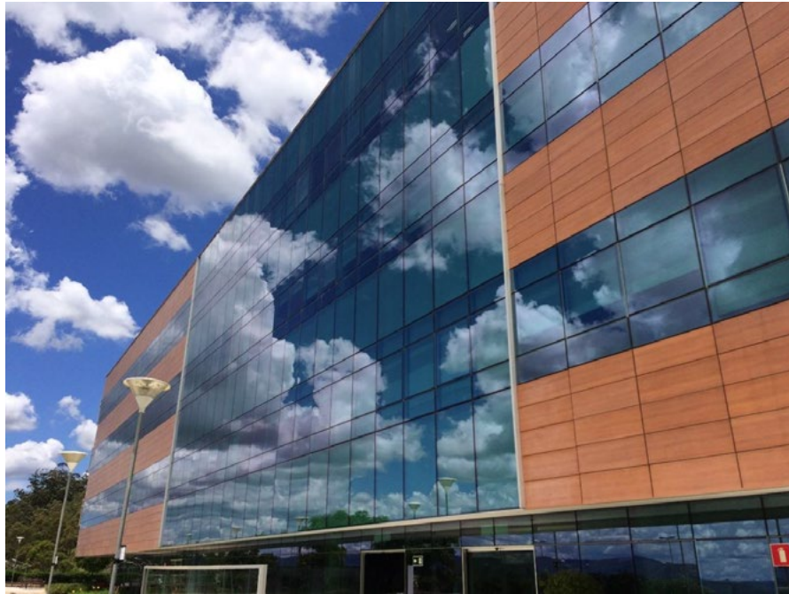
FACHADA DO EDIFÍCIO ÁGUAS CLARAS (CVRD PRÉDIO IV)
