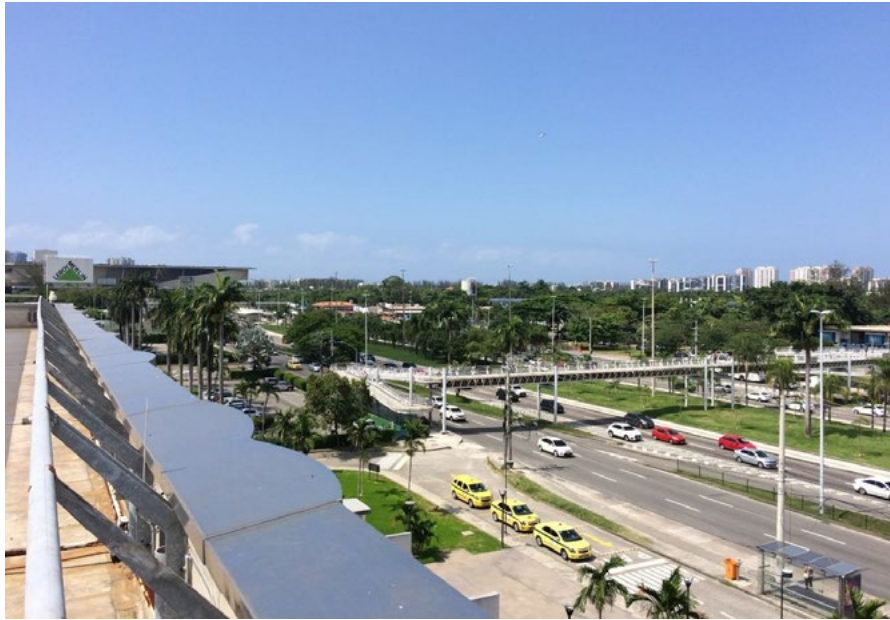
ACESSO EDIFÍCIO – AVENIDA AYRTON SENNA
