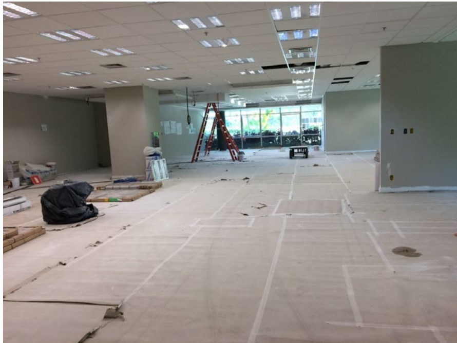
ÁREA EM REFORMA PARA OCUPAÇÃO – 1º PAVIMENTO
