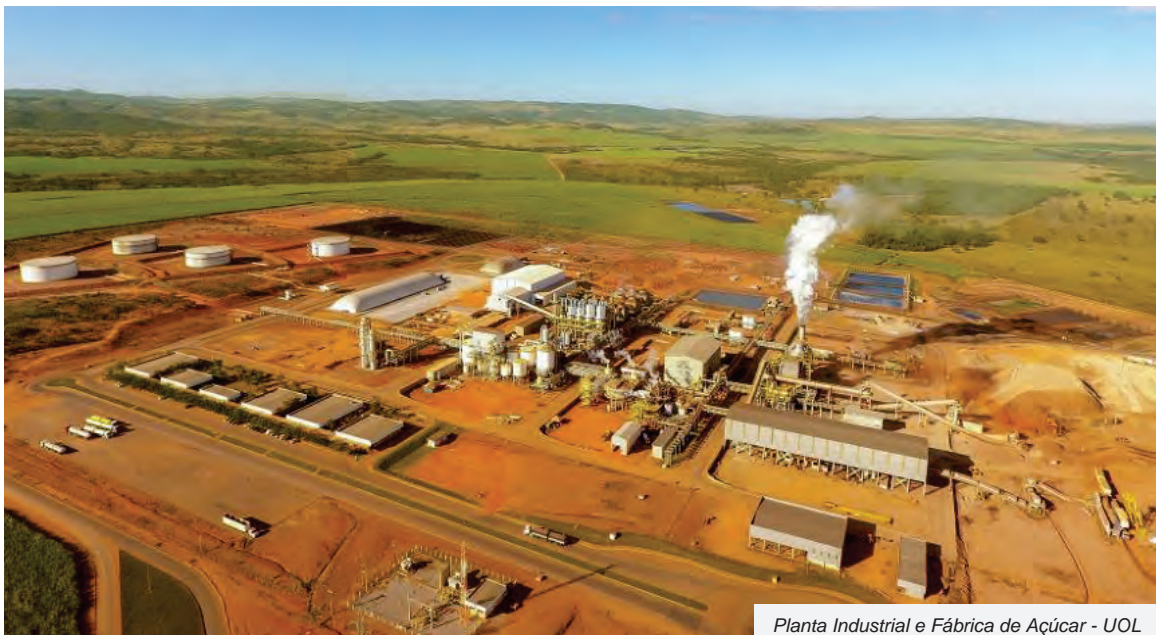
Planta Industrial e Fábrica de Açúcar - UOL
