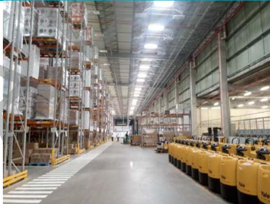
VIA VAREJO - GALPÃO
