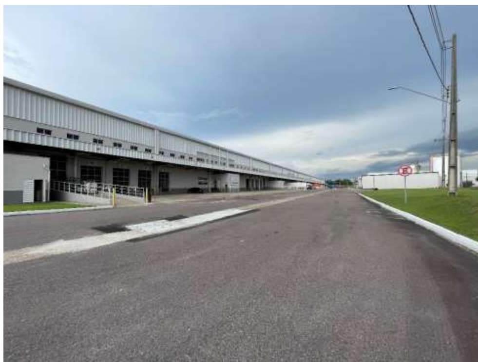
Vista geral do imóvel
