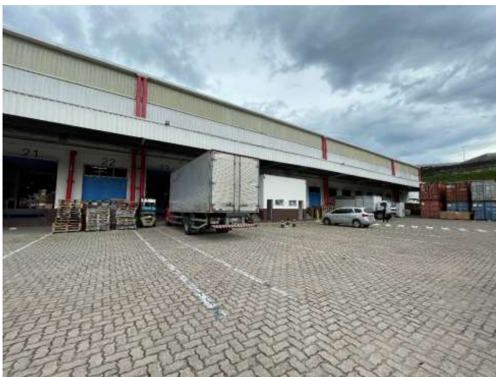
Vista interna do imóvel
