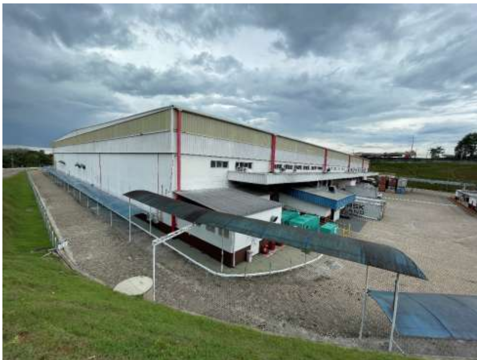
Vista geral do imóvel
