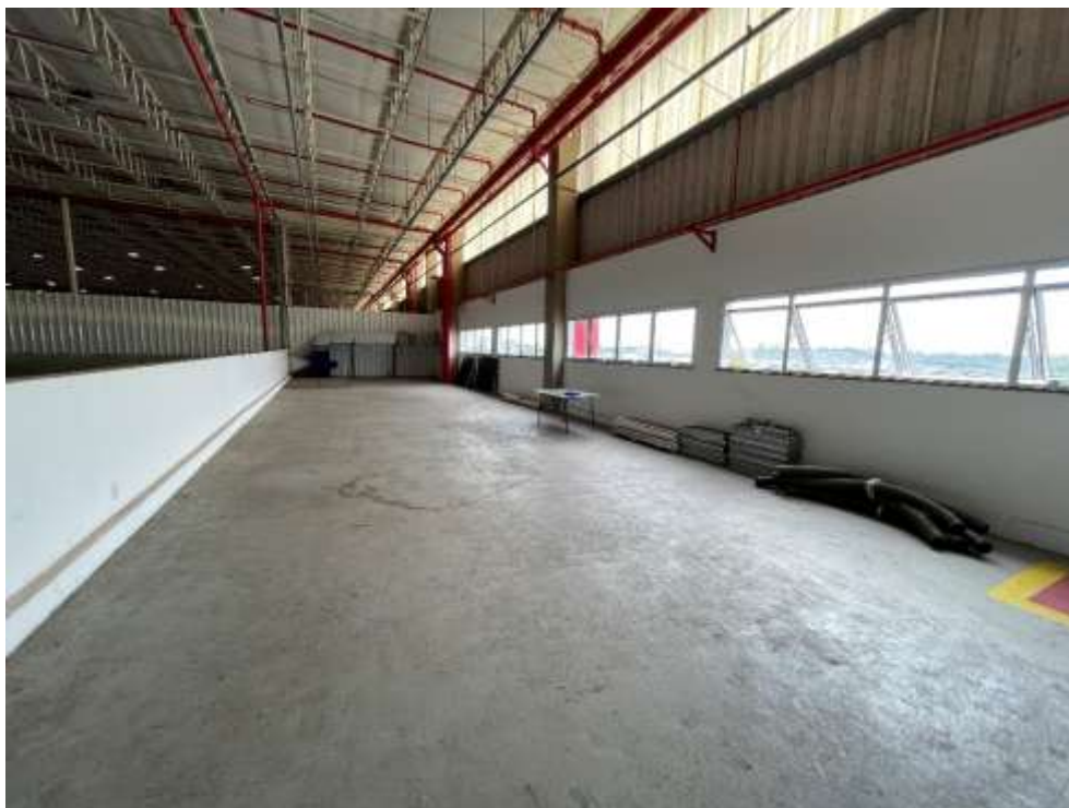
Vista interna do imóvel
