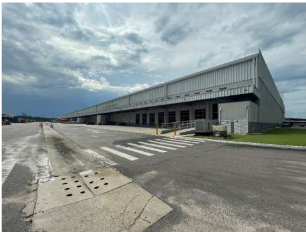
Vista geral do imóvel
