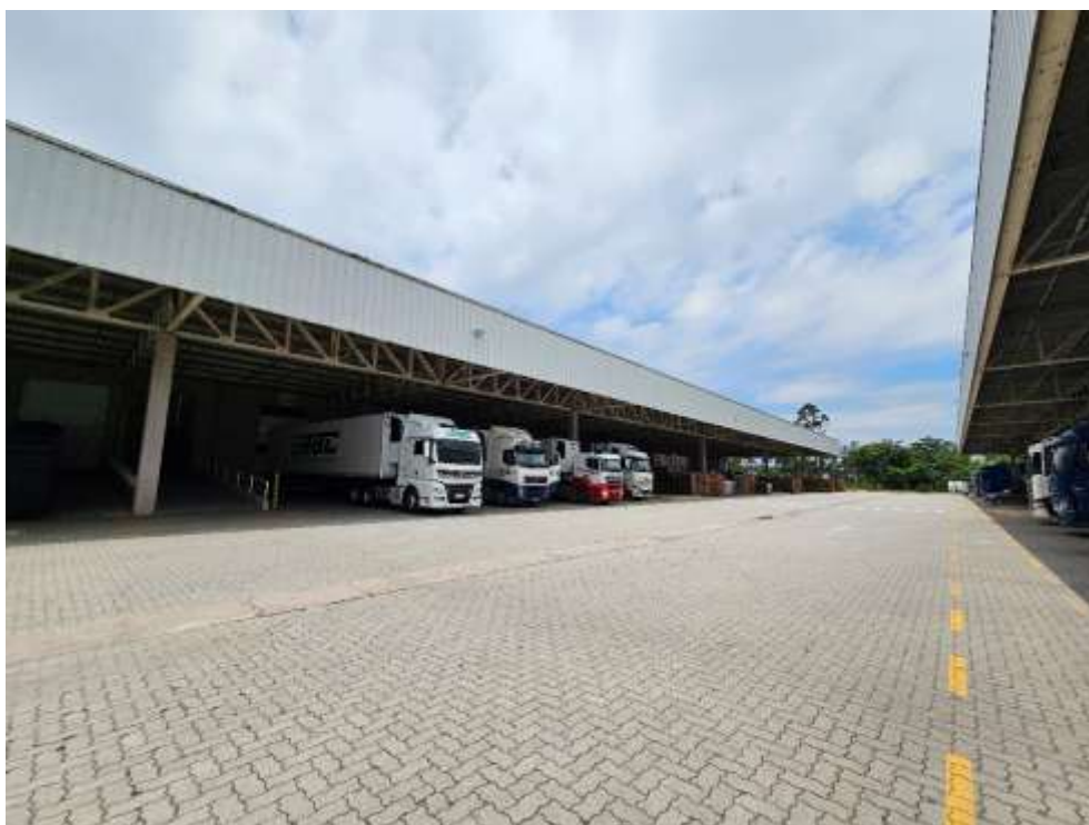
Vista interna do imóvel
