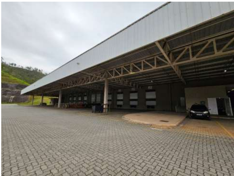
Vista interna do imóvel
