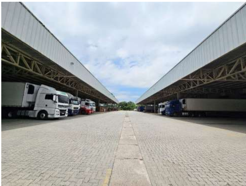
Vista interna do imóvel
