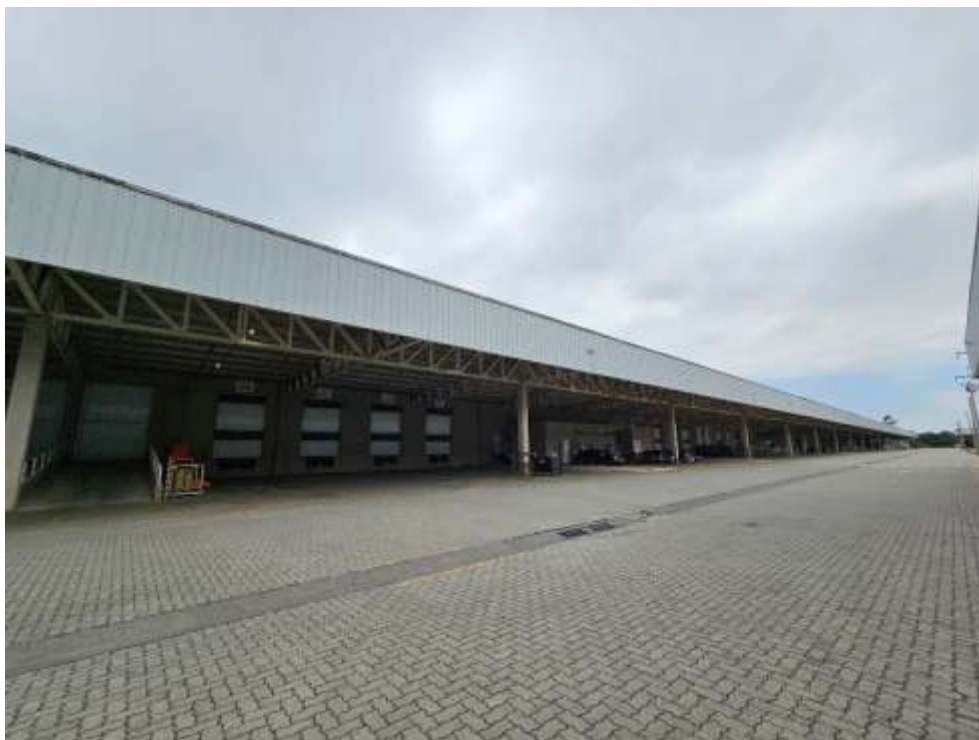
Vista interna do imóvel
