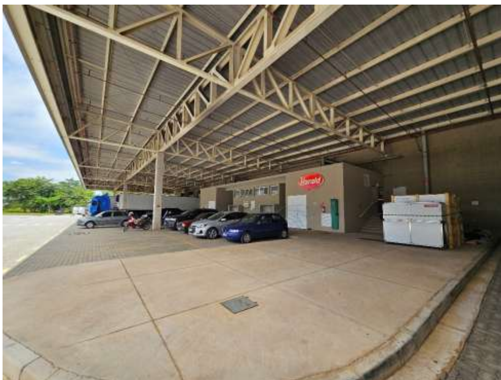
Vista interna do imóvel
