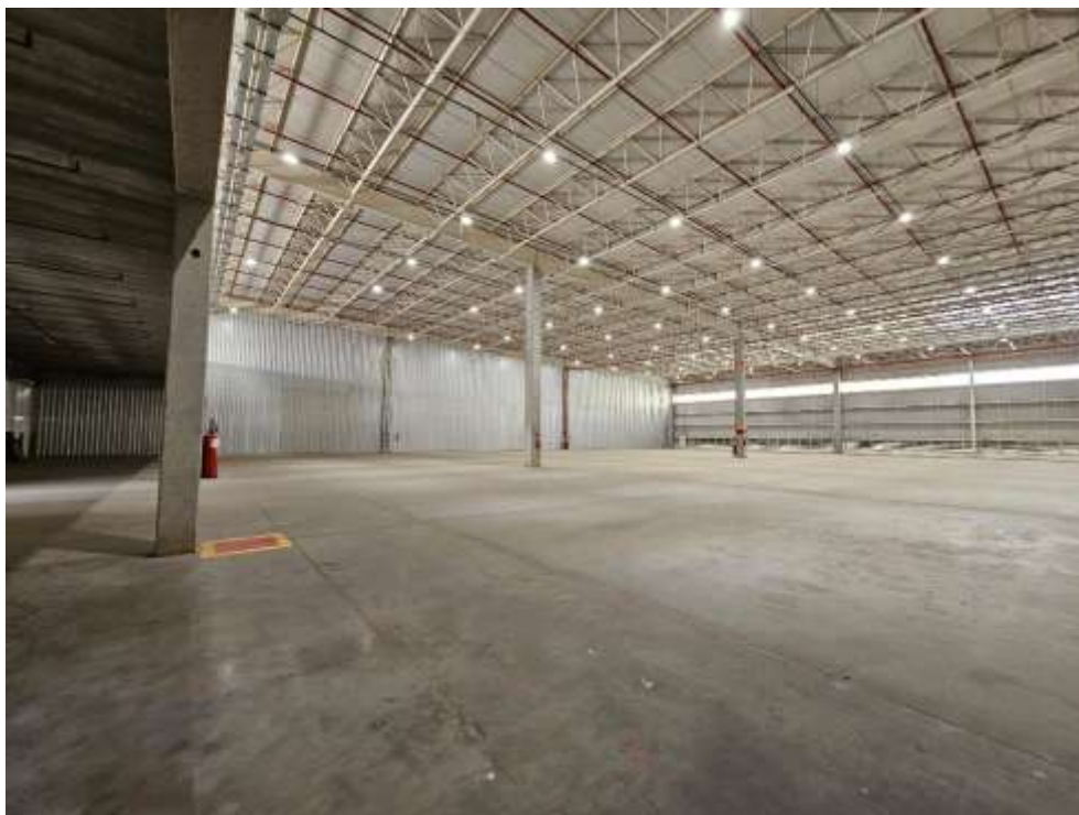
Vista interna do imóvel
