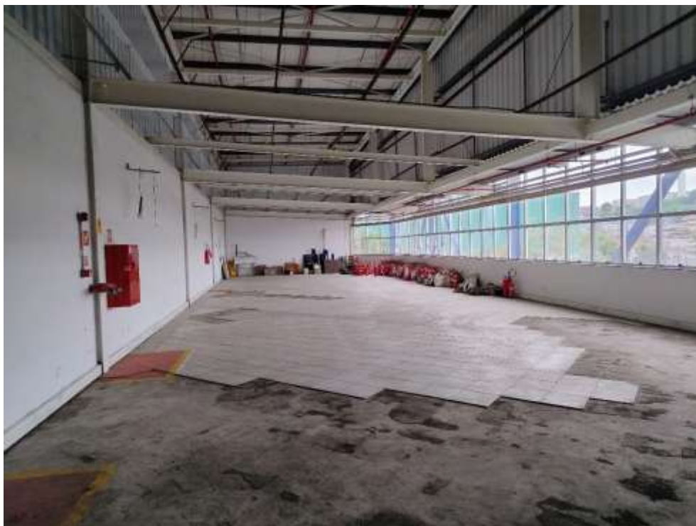
Vista interna do imóvel
