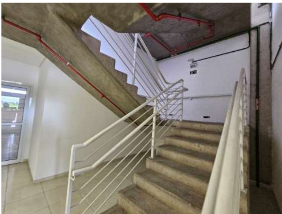
Vista interna do imóvel
