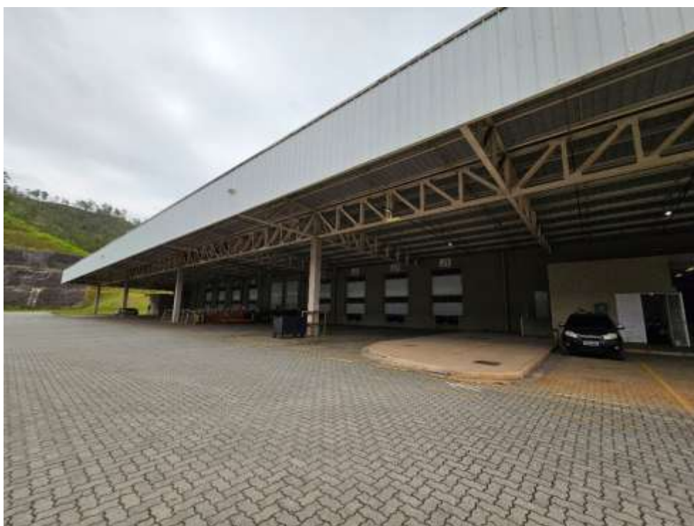
Vista interna do imóvel
