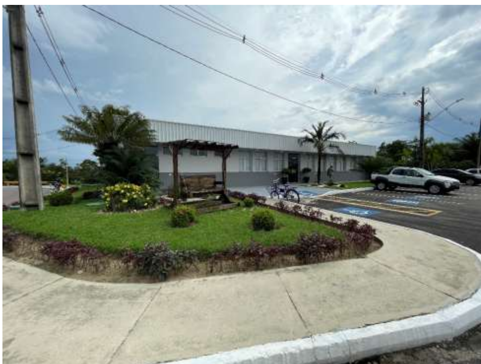
Vista geral do imóvel
