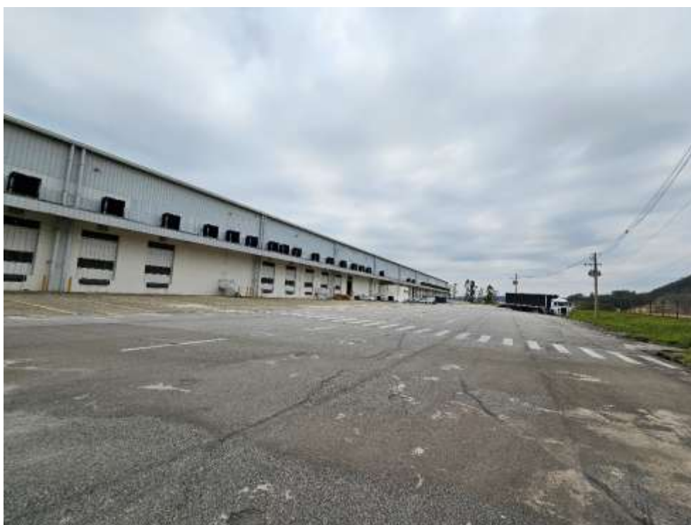
Vista interna do imóvel
