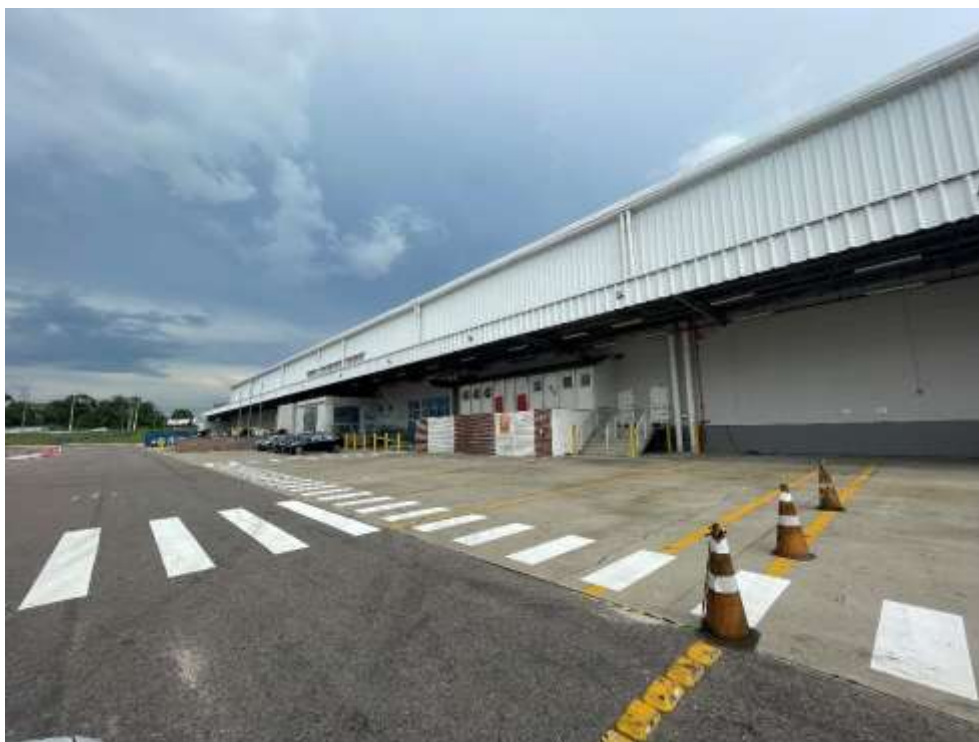
Vista geral do imóvel
