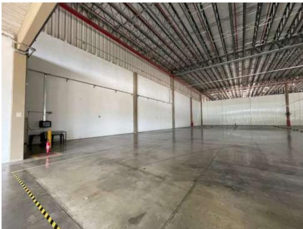
Vista interna do imóvel
