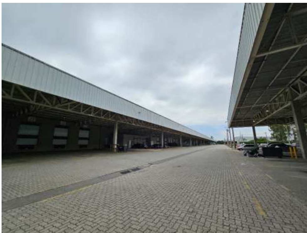
Vista interna do imóvel
