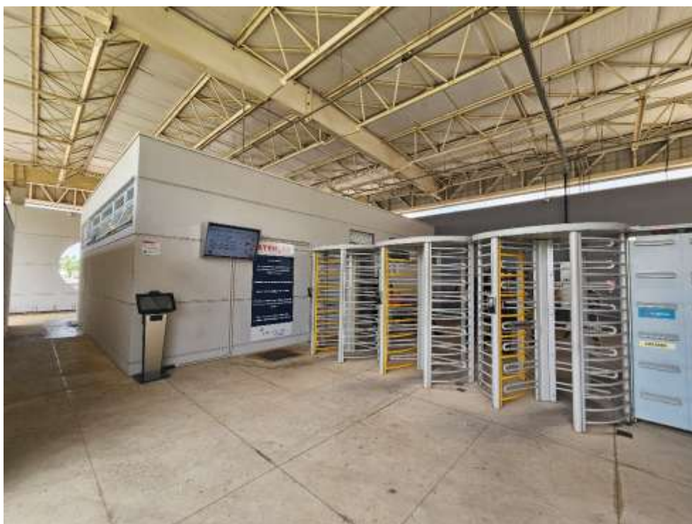
Vista interna do imóvel
