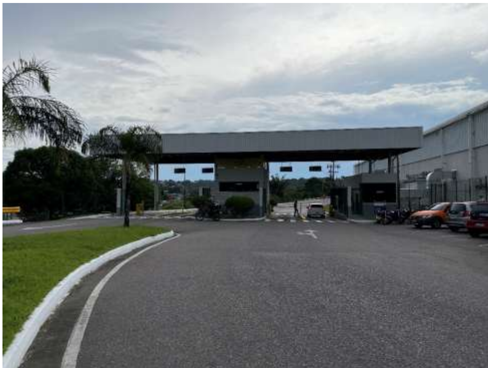
Portaria do imóvel
