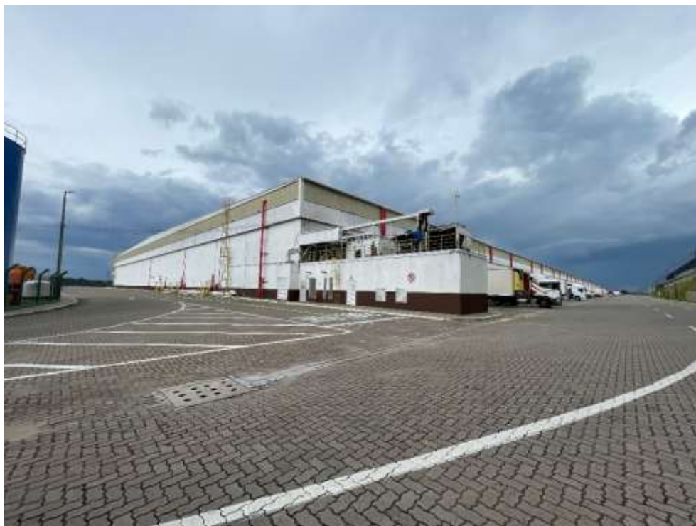
Vista interna do imóvel
