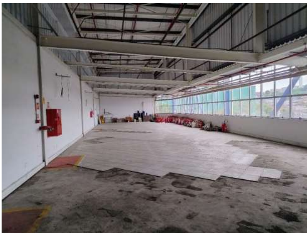
Vista interna do imóvel
