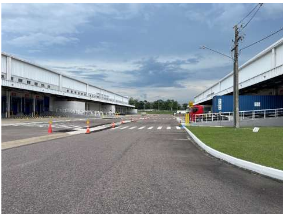
Vista geral do imóvel
