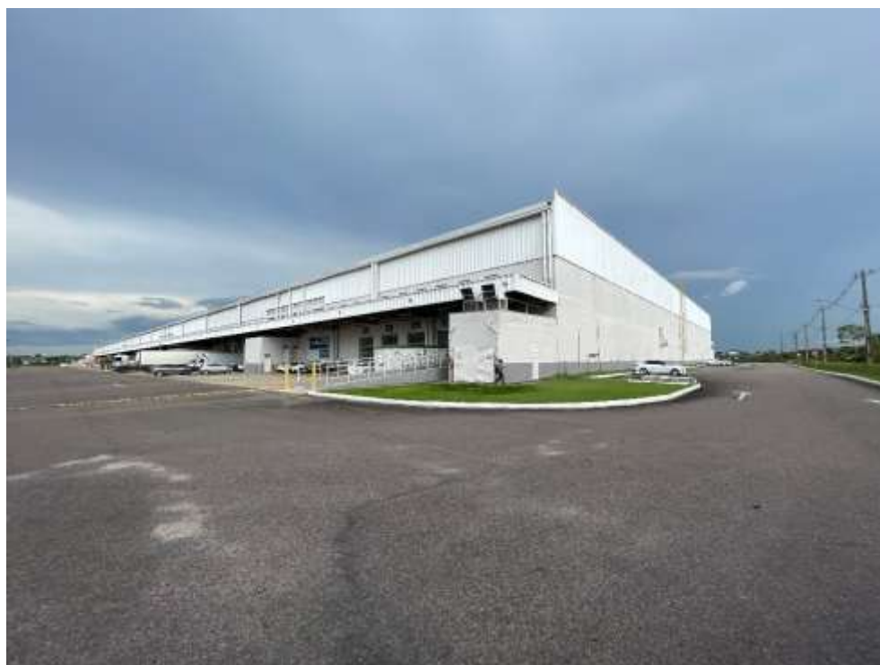
Vista geral do imóvel
