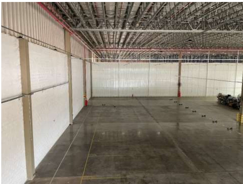
Vista interna do imóvel
