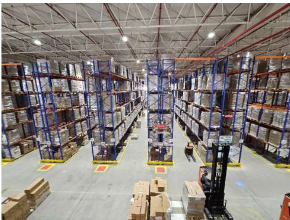
Vista interna do imóvel
