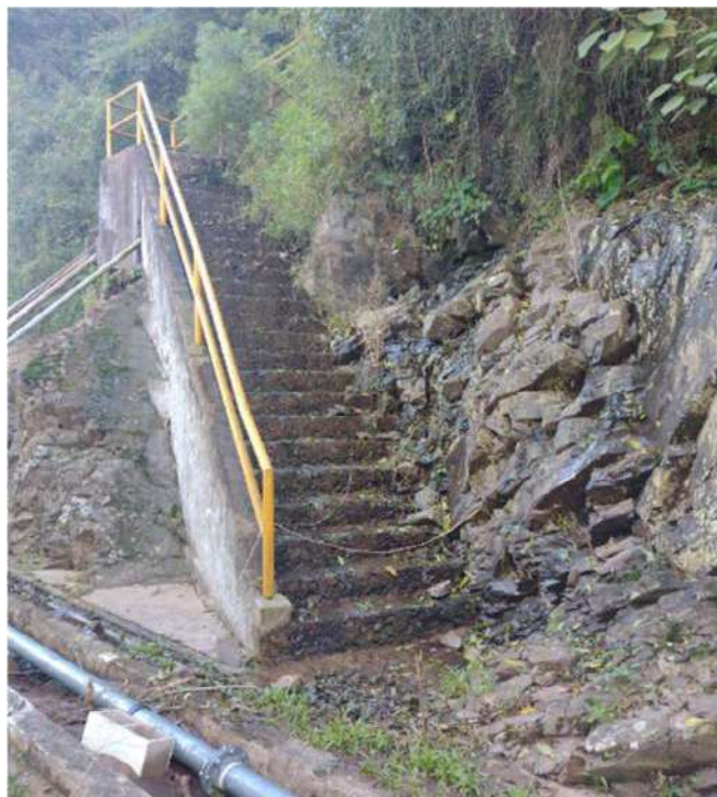
Figura 4 - Remover degraus até altura de 2m
