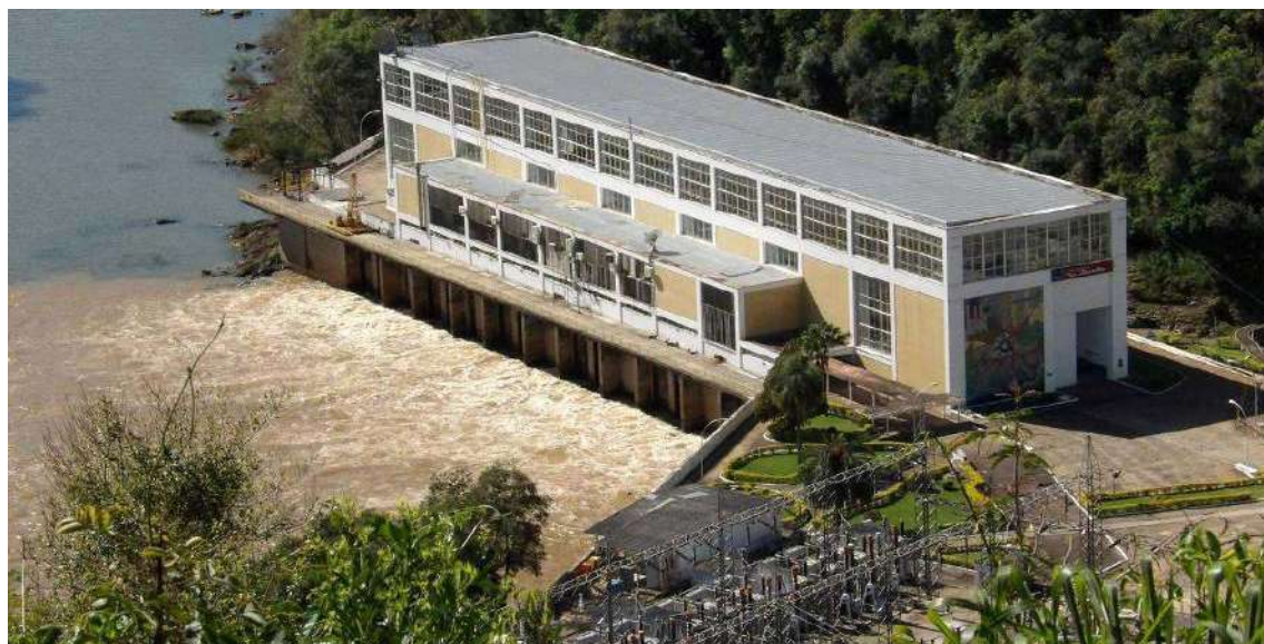
Figura 1 - Fachada frontal de jusante, Noroeste - UHE - Jacuí
