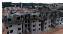
Industrializado com formas de alumínio e paredes de concreto
