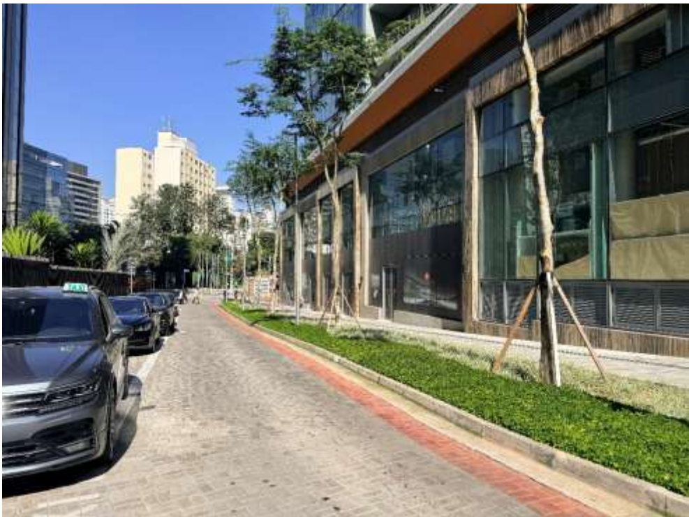
Via de acesso ao imóvel
